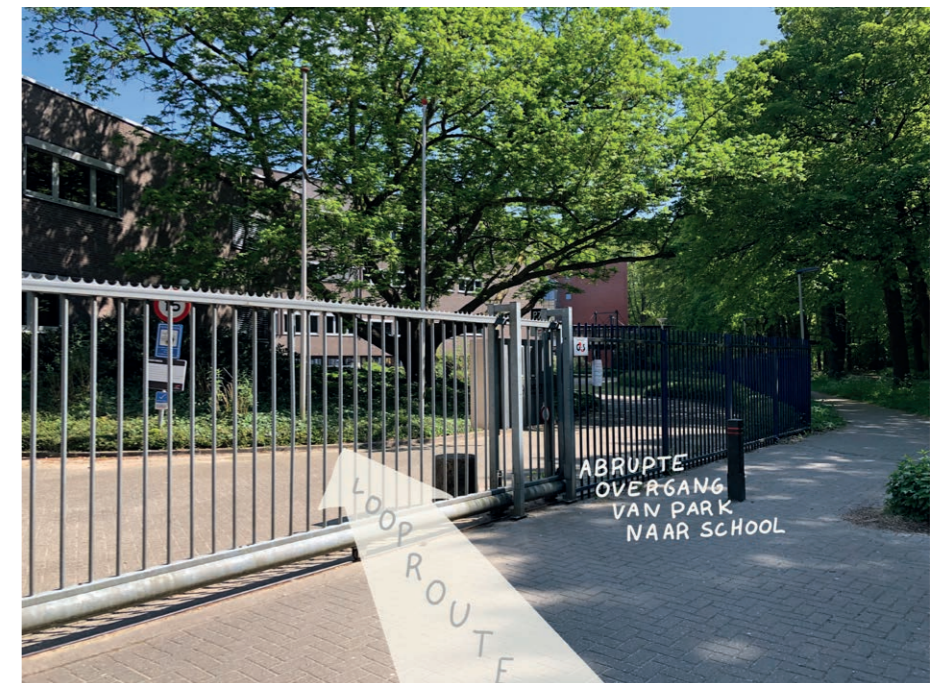
figuur 2.14: Station Presikhaaf – HAN, Abrupte overgang, hekwerk niet uitnodigend
