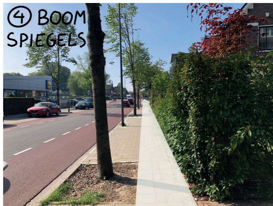
figuur 6.5: Boomspiegels in trottoir
