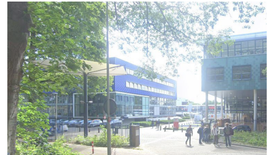
Afbeelding 10 Hoofdingang naar het oude hoofdgebouw van de campus.
