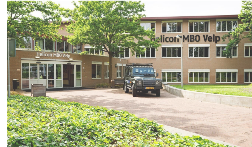
Afbeelding 44 Het gebouw van Yuverta.
