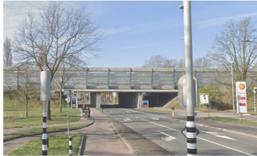
Afbeelding 37 Viaduct onder de A12.
